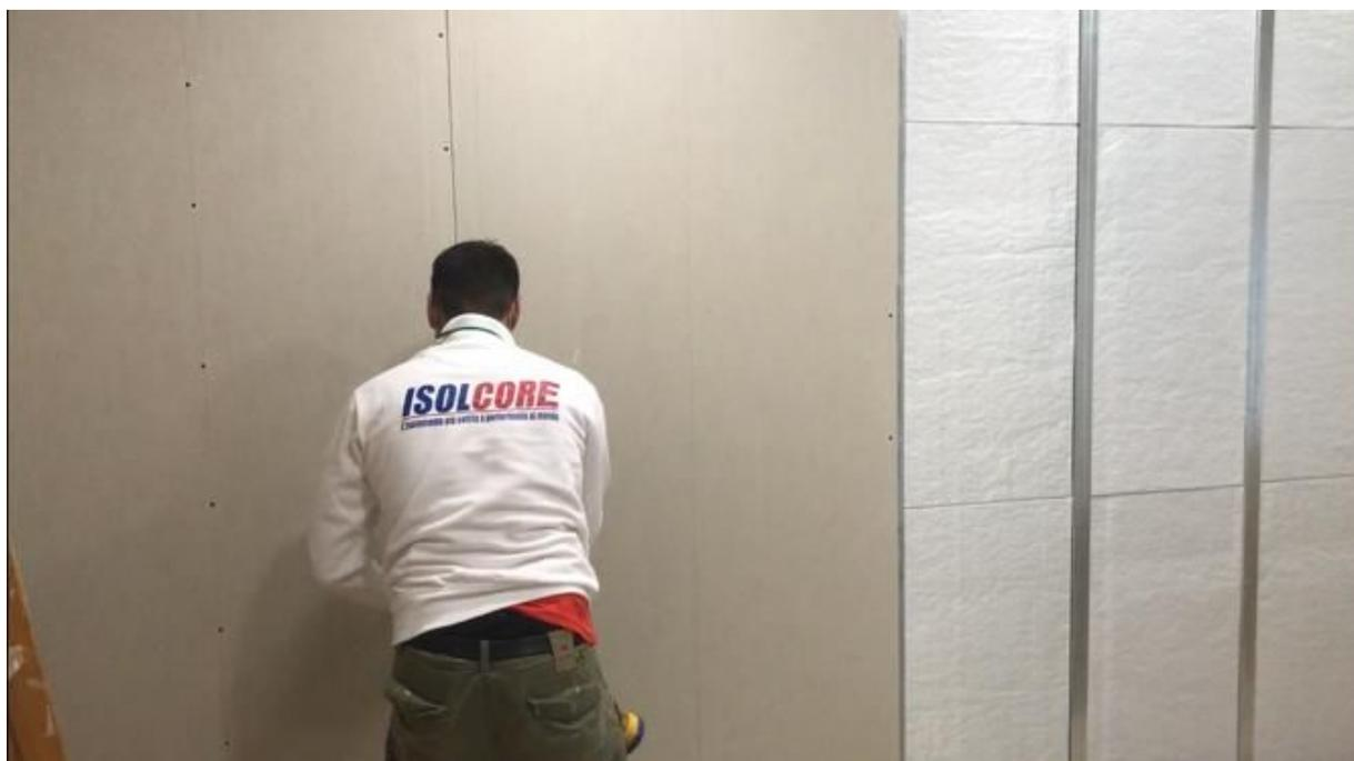
Regolare la punta dell'avvitatore in modo che le viti siano alla giusta profondità, con la testa perfettamente a filo del rivestimento della lastra. Le viti devono essere poste a ca. 1 cm dal bordo longitudinale della lastra e a ca. 1,5 cm dal bordo di testa .
