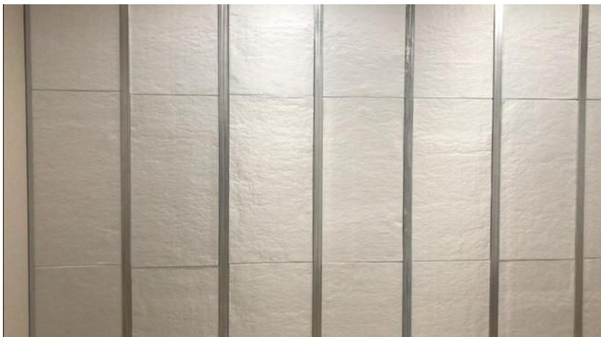
Attenzione: esercitare una leggera pressione tra pannello e pannello per eliminare le eventuali fughe. E' possibile sigillare le fughe nastrandole con il nastro adesivo argentato ISOL-TAPE tipo "americano".
