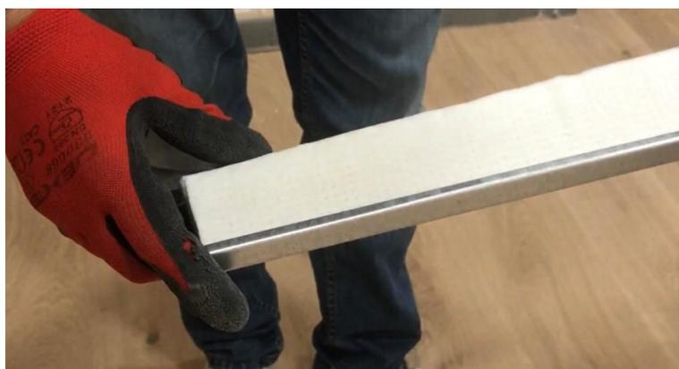
**Note:** Nel caso di problemi di spessore dove non sia possibile applicare i 3 cm totali è possibile nel caso la parete sia dritta e l'altezza non superiore ai 3 metri, di applicare la struttura senza il cavaliere recuperando così 5 mm di spessore e arrivando ad uno spessore totale di 2,6 cm circa.
