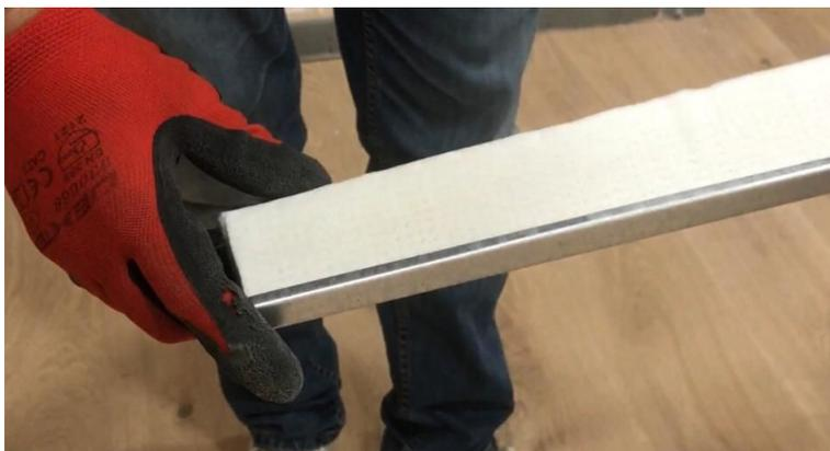
**Note:** Nel caso di problemi di spessore (es nicchie balconi, atrio, etc) dove non sia possibile applicare i 3,6 cm è possibile nel caso la parete sia dritta e l'altezza non superiore ai 3 metri, di applicare la struttura senza il cavaliere recuperando così 5 mm di spessore e arrivando ad uno spessore totale di 3 cm circa.
